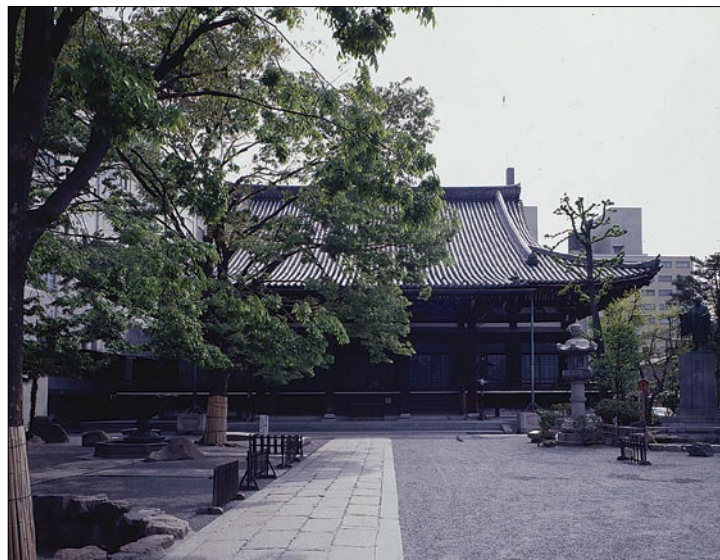
屋根瓦修復事業を行う本能寺本堂
