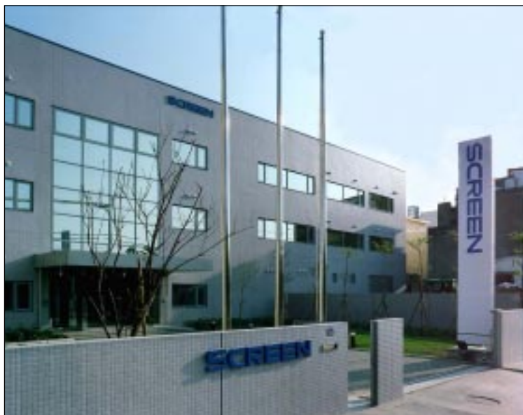
台湾テクニカルセンター兼事務所(正面)
