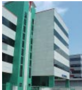
敷地面積1,437平方メートル、のべ床面積約2,811平方メートル、鉄筋コンクリート5階建
