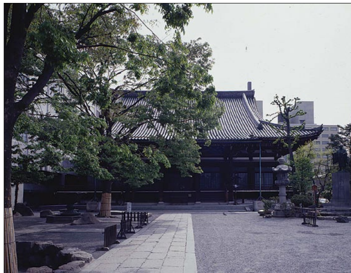
屋根瓦修復事業を行う本能寺本堂
